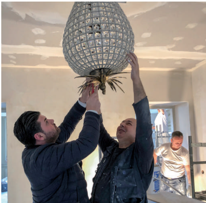
Rénovation Quai Gustave-Ador Genève, Suisse 2018 - 2019
