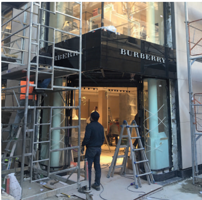
Burberry Rénovation Atelier Genève, Suisse 2017 - 2018
